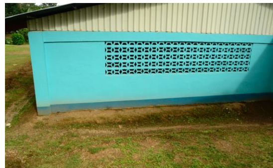
An dieser Stelle des Schulgebäudes werden wir den Gehweg bauen
